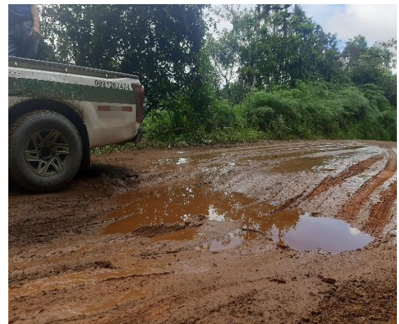
Hundimiento vial Santa teresita aproximadamente 60 cm de profundidad
