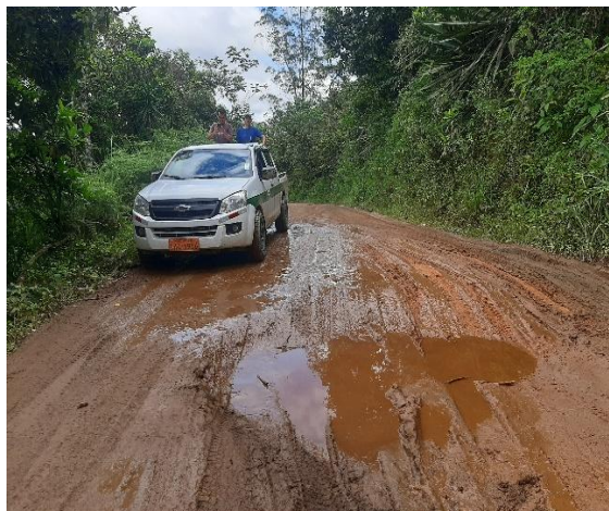
Hundimiento vial Santa teresita aproximadamente 60 cm de profundidad
