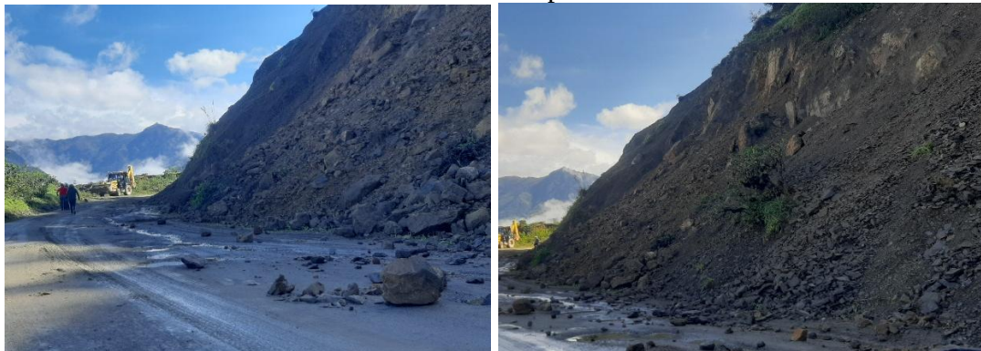
Gráfico 19. Deslizamiento activo de aproximadamente 60 a 70 metros de largo
