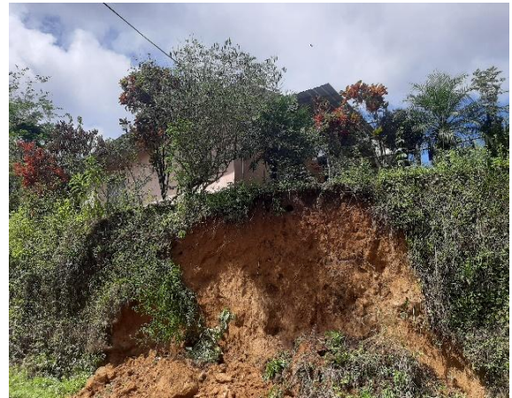
Casa en riesgos de colapsar
